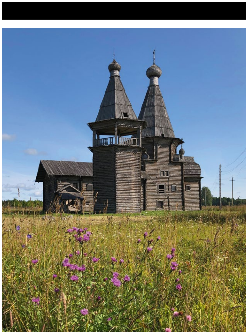
Деревянная церковь Иоанна Златоуста Саунинского погоста
